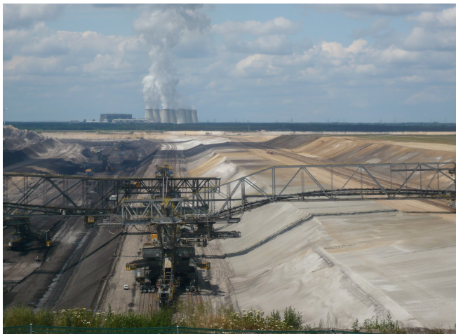
Braunkohle-Kraftwerk bei Jänschwalde, guentherhh, CC BY 2.0
