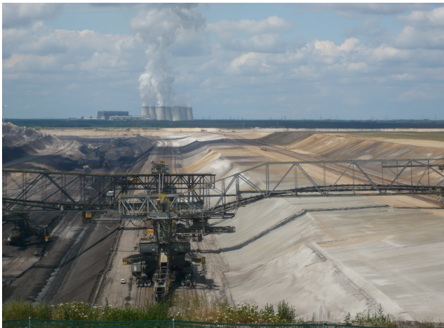
Braunkohle-Kraftwerk bei Jänschwalde, guentherhh , CC BY 2.0
